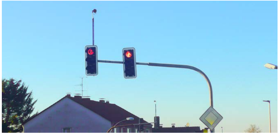
Die Ampelanlage an der Kreuzung „Flora“ wurde modernisiert.
