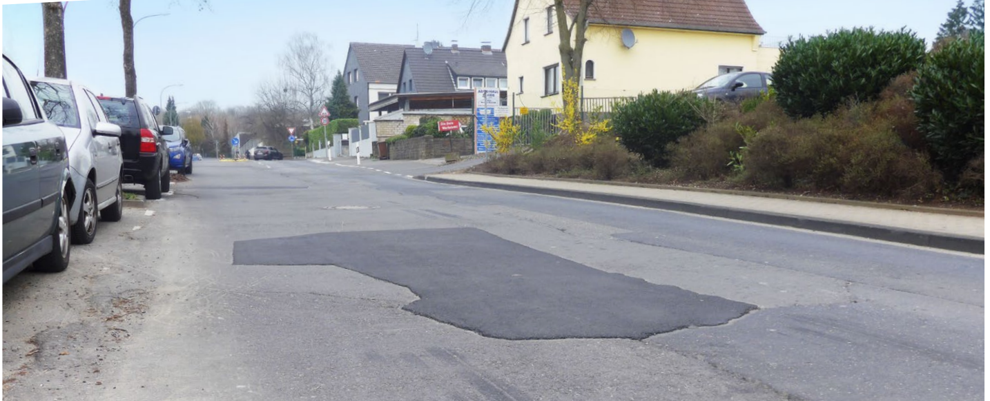
Viele Straßen in Bergisch Gladbach wie die Buchholzstraße sind nur notdürftig repariert und brauchen eine gründliche Erneuerung.
